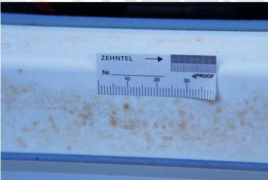
Deze verkleuringen worden veroorzaakt door vliegroeft, wat resulteert in puntige gele vlekken.
